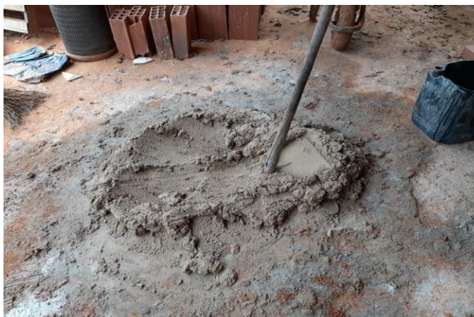
Figura 7: A mistura do traço de massa com água.
