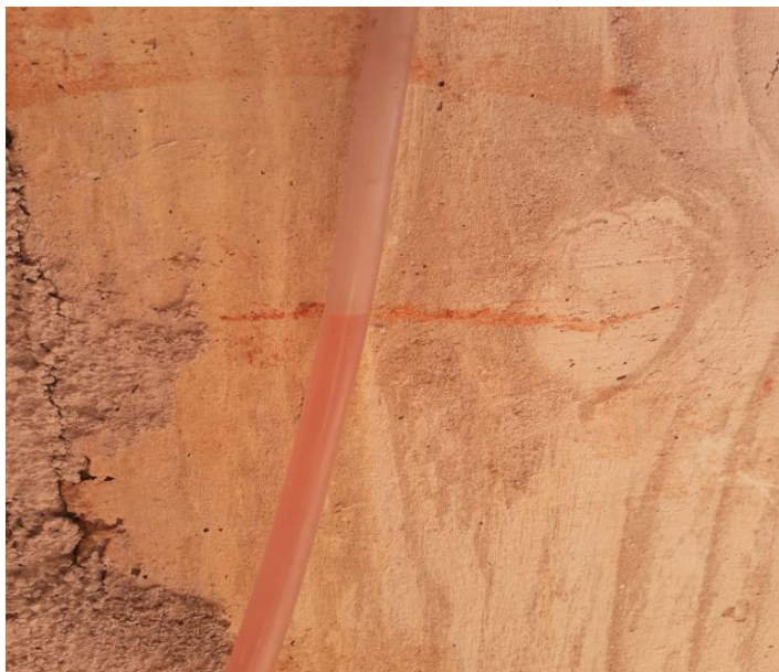
Figura 3: O uso da mangueira de nível 1.
