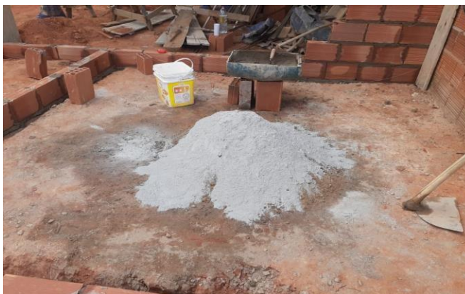
Figura 6: A mistura do traço de massa sem água.
