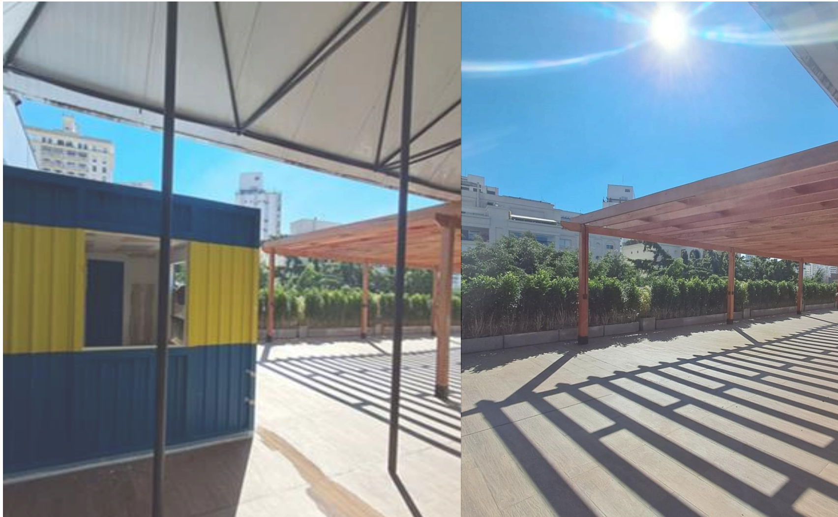
Vista de área de convivência (externa) em fase de implantação na Unidade Perdizes – Prédio São José e Santa Marcelina
